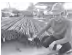
图 3.1.3 钢筋到场验收
