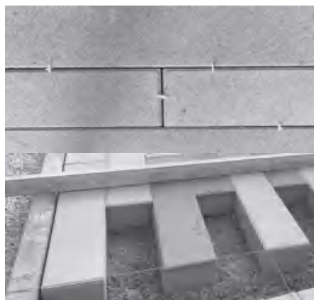
图 3.2.8 专用缝卡，平整度检测
