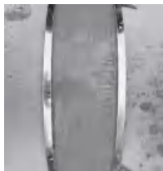
图 4.10 管道抹带条
