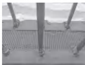
图 4.14 免凿毛止浆带
