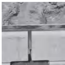
图 4.11 管道抹带条
