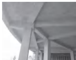
图 3.1.11 混凝土节点实体
