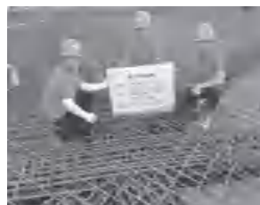
图 3.1.9 节点钢筋实体验收
