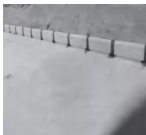
图 4.11 管道抹带条
