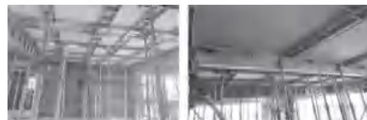
装配式建筑叠合楼板铝膜板带+YJ型钢支撑施工工法
