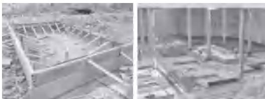
②采用充气囊作为梁柱核心区混凝土高低标号
