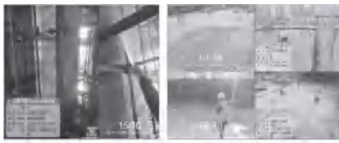
④实体验证。项目对可进行回弹的构件，及时进行实体回弹。建立混凝土强度回弹台账，记录回弹值并进行分析，对强度值有差异的构件进行跟踪关注。
