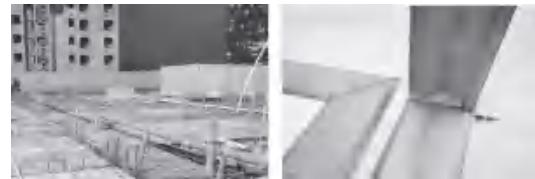
高低标号混凝土充气棒拦截    预制化止水钢板
