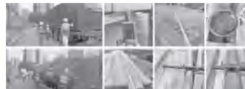
②钢筋材料管理：以云筑智能地磅、收验货系统为主要载体，结合视频监控系统，完成核对凭证、外观质量验收、数量验收和检测报告四步验收。并对直条钢筋全量点数，散捆抽检查长短肢，分类标识堆放。抽查复检。
