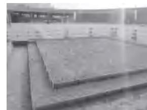
图 2.1.11 足球场结构层样板
