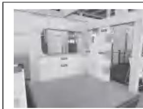
二次结构样板：有水房间浇筑不低于 200mm 混凝土反坎；构造柱马牙槎应从每层柱脚开始，先退后进，马牙槎高度不应超过 300mm，进退尺寸不宜小于 60mm。墙体砌筑灰缝饱满，门窗洞口留置位置准确。
