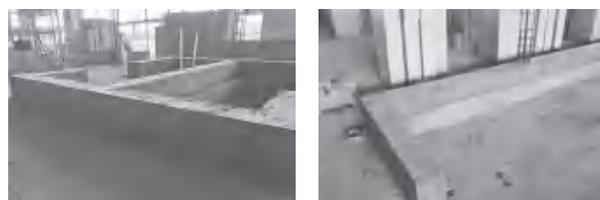
图12 反坎成型效果
