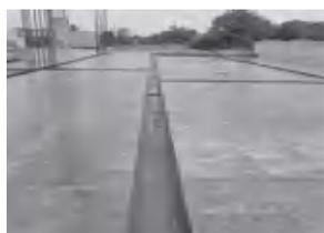
图6 梁板模板安装
