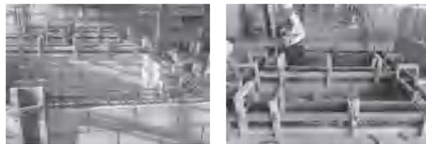
图11 圈梁、反坎模板加固采用定型夹具
