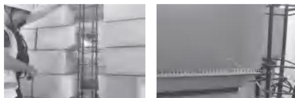
图13 马牙槎砌筑带线
