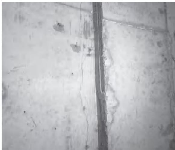
图1 混凝土墙板典型竖向裂缝
