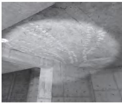
(材料堆场超设计荷载引起开裂渗水)
