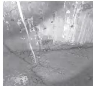
（地下室外墙与底板交接处后浇带渗水）
