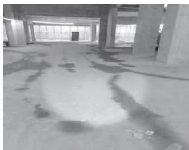
(混凝土振捣、养护不到位渗水)
