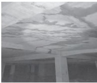
(外部动荷载引起结构开裂渗水)
