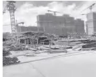
(混凝土浇筑后过早集中堆放钢管、模板等材料)
