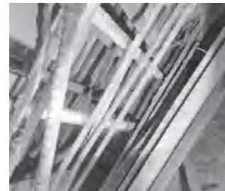
（地下室外墙与底板交接处后浇带浇筑前处理不到位）
