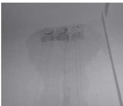
(地下室外墙穿墙套管处理不当引起渗水)
