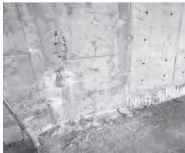
(地下室外墙接缝处混凝土粗糙并渗漏)
