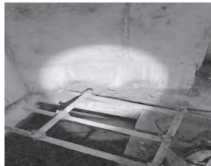
(地下室外墙螺杆洞封堵不到位渗水)
