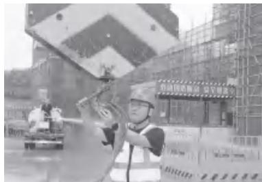
图为郭宏伟在检查宜都夷水路棚户区项目塔吊吊钩磨损情况
